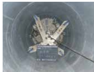
リターン回収状況(駆動一体)
