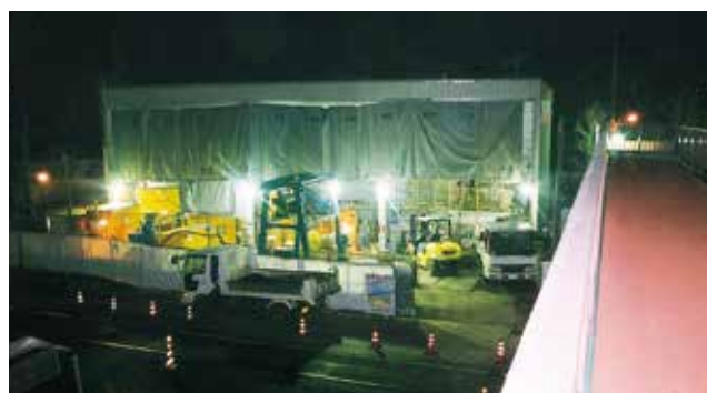
推進設備全景 (一次分離処理方式、防音ハウス)
