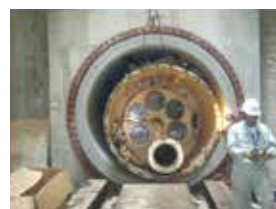
掘進機駆動部引戻し状況
