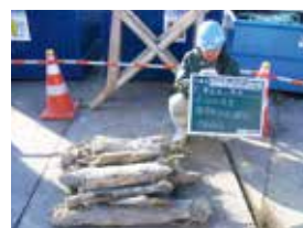
障害物摘出：木杭
