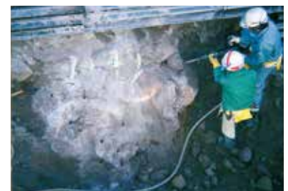
①発進立坑土質状況 岩盤人力掘削状況： Max2000mm以上
