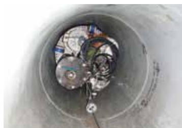
内部駆動装置リターン回収状況
