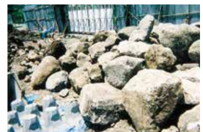
②立坑掘削時の摘出玉石 カームマイト等使用(小割り)
