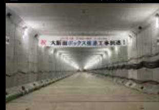
□7400×4600mm 地下連絡通路完成
