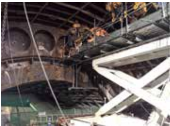
施工状況(ユニバーサル架台使用)
