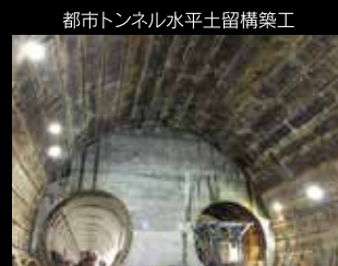
都市トンネル水平土留構築工
