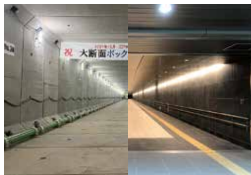
左：施工中、右：完成した地下通路
