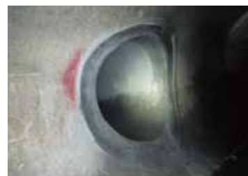
既設シールド接合部ライニング完了
