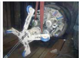
リターン回収状況(駆動一体)
