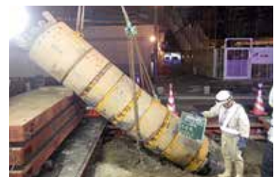
掘進機回収状況②
