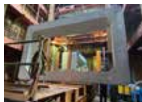
函体吊り降ろし状況
