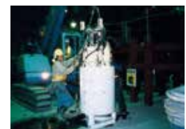
リターン回収型掘進機(再組立時)
