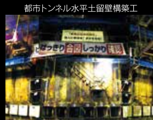
都市トンネル水平土留壁構築工
