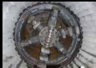
既設暗渠直接切削到達完了
