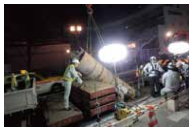
掘進機回収状況①
