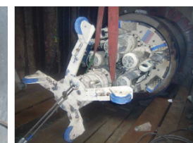
リターン回収状況(駆動一体)
