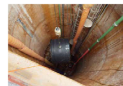
狭小発進立坑(大深度)
