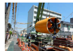
掘進機投入状況
