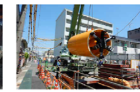
掘進機投入状況
